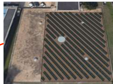
Puissance à installer : 94,5 kWc
