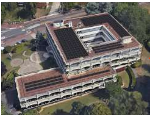
Puissance à installer : 99,6 kWc
