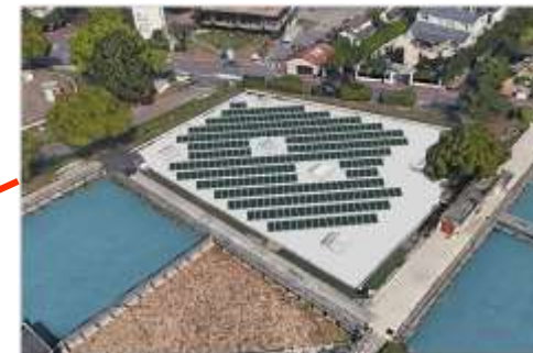
Puissance à installer : 99 kWc
